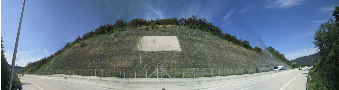
영천절토 34 (관리이정 1.890~2.150km / 5공구 군위R-A(중양)STA.1+890~2+150)
